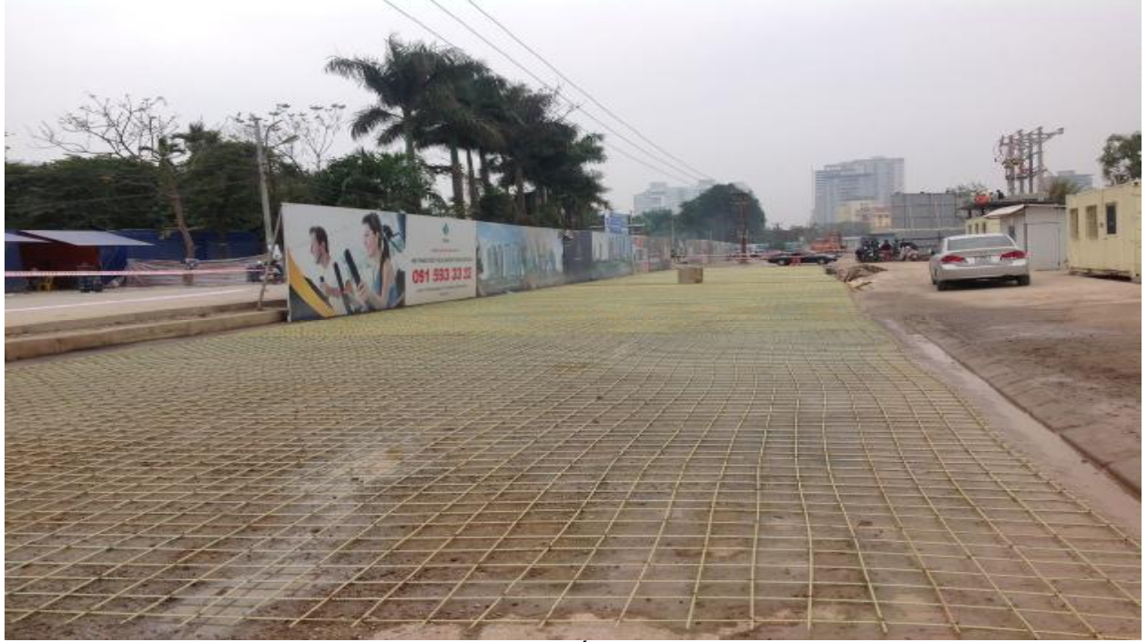
Bê tông mặt đường dùng dùm cốt FRP
