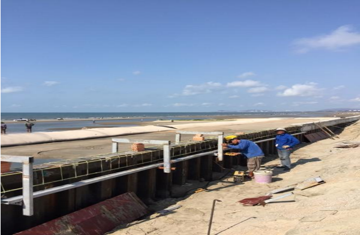
Hoàn thiện cừ bờ biển
